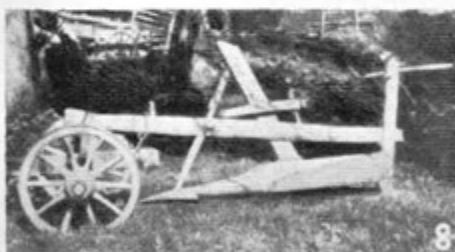
Štajersko-koroška četrrokotna rala iz teh-le krajev: 1. Bilčovs, 2. Radvanje (s prestavljivo desko), 3. Mlinče, 4. Zorhnji kot pri Selah, 5. Plešivec nad Kotmaro vesjo, 6. Rute pri Podgorju (ročica in plaz iz enega kosa lesa), 7. Sp. Kapla (Kobansko), 8. Vobrske gore (s prestavljivo rezalnico; zadnja presta bi morala biti pravilno zataknjena zadaj za zdržnikom)
