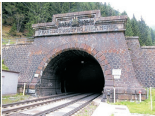
Portal Tauertunela, predora pod Visokimi Turami.
