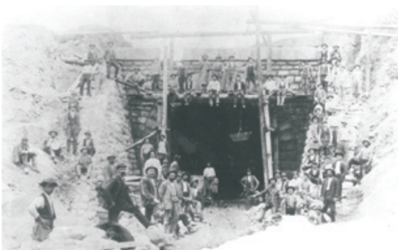
Zahodni portal predora Bukovo, 1903.
