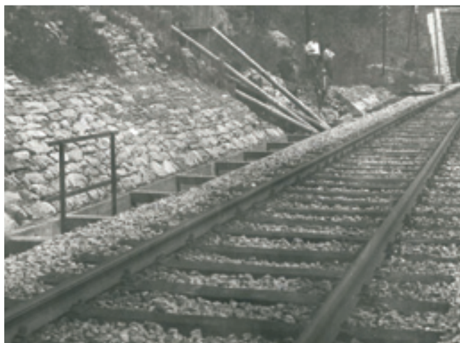
Urejanje odvodnjavanja v Lutah, delovodja Albin Lenar.
