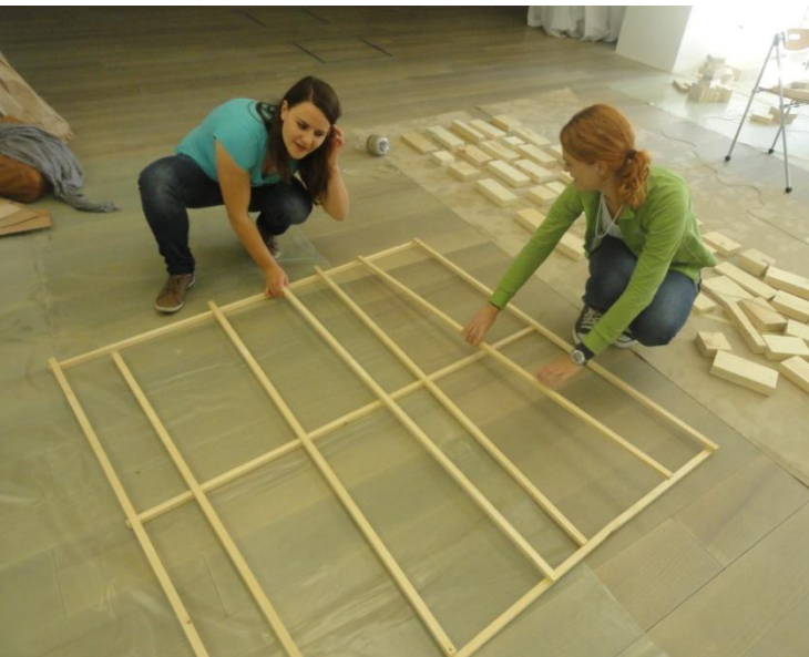
PRIPRAVA OSNOVNE KONSTRUKCIJE
