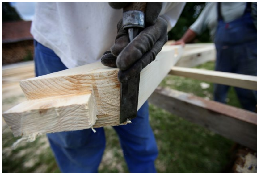
Tesarski mojster Janko Gregorčič pri postavljanju kozolca v Šentrupertu na Dolenjskem, 2011 (foto Matej Povše, Dokumentacija SEM)
