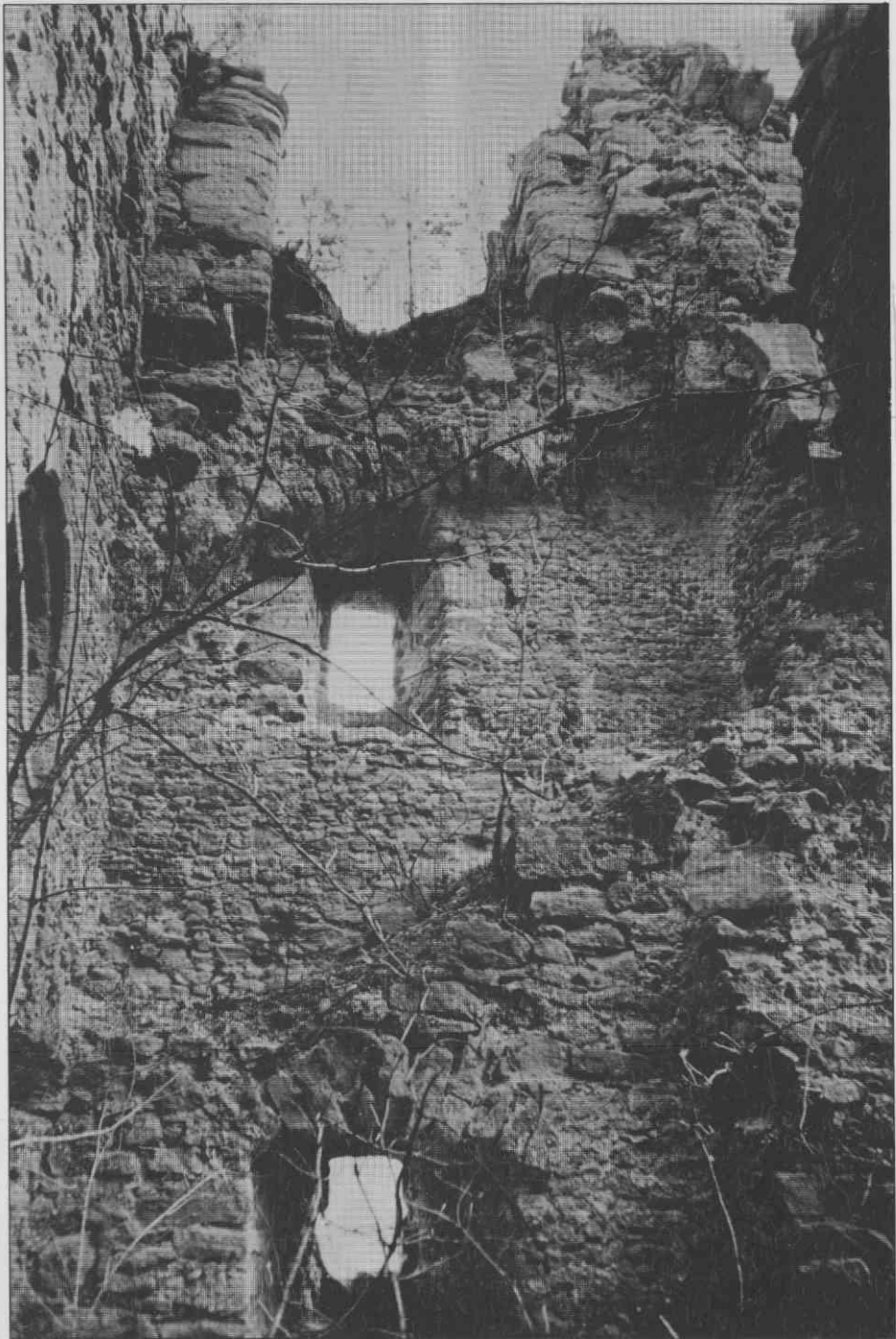
Sl. 11. Južna stena osrednjega dela Friderikove hiše leta 1987. Spodaj je okno 4, v sredini so stopnice 24 in podest stopnišča v zidu 25; zgoraj so ostanki pohodne okenske niše 12.
