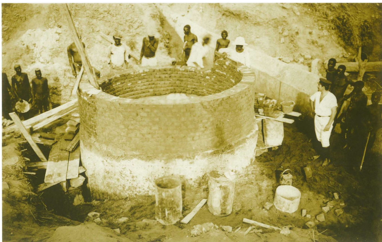
31. Zidanje vodnega zbiralnika. / Construction of a water cistern.
