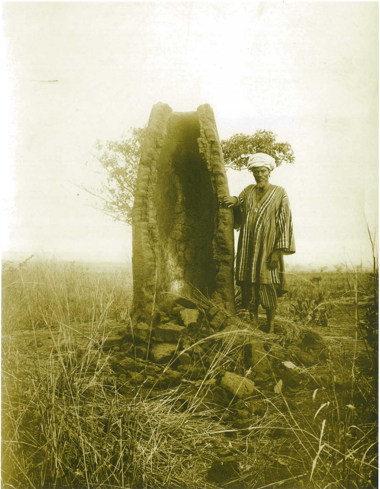
149. Vaški poglavar pred podrto železarsko pečjo v okolici kraja Bassar v zahodnem Togu. / Village chief in front of a collapsed blast furnace near Bassar in western Togo.
