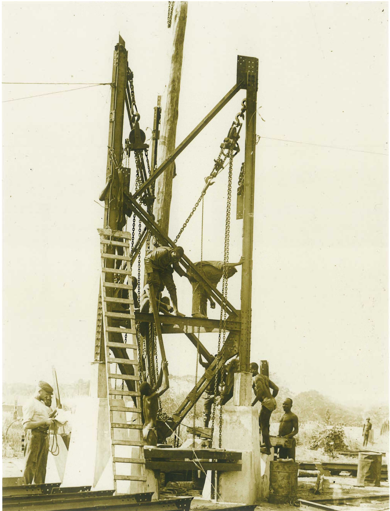
46. Montaža jeklne konstrukcije antenskega stolpa. / Assembly of the steel construction of the antenna tower.
