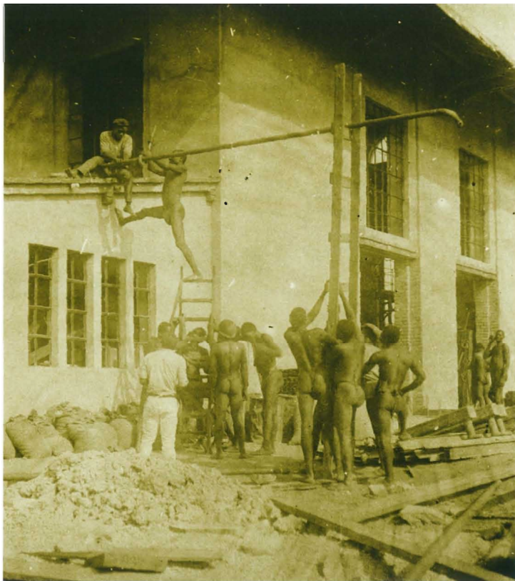
65. Montaža cevi za vodo. / Installation of water pipes.
