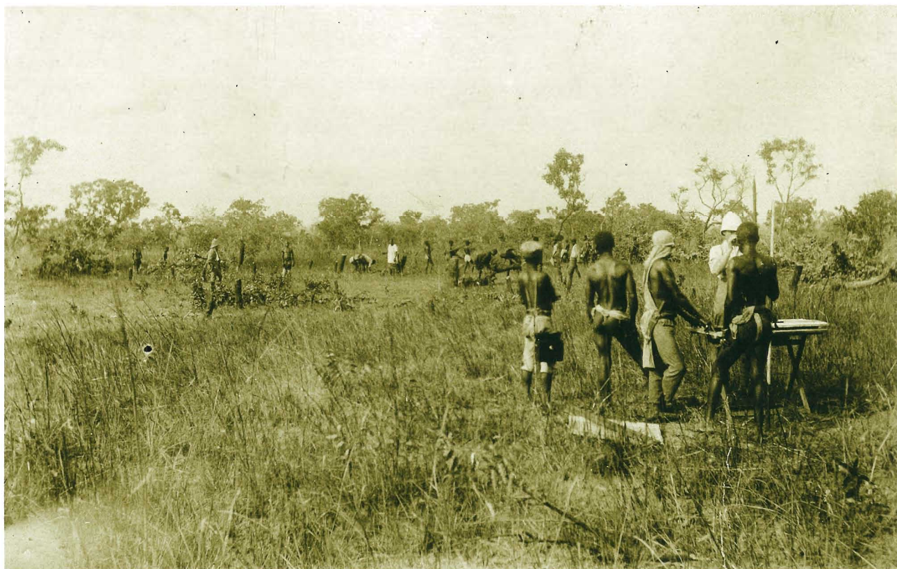
28. Čiščenje terena ob začetku gradbenih del v Kamini. / Clearing the terrain before the beginning of construction works in Kamina.
