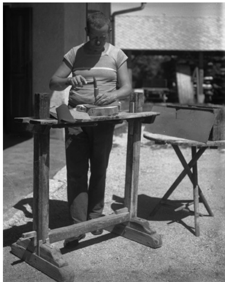
Peter Naglič izdeluje pločevinaste šablone za lesne osnove ščetk na dvorišču tovarne okoli leta 1930. (foto: Peter Naglič)
