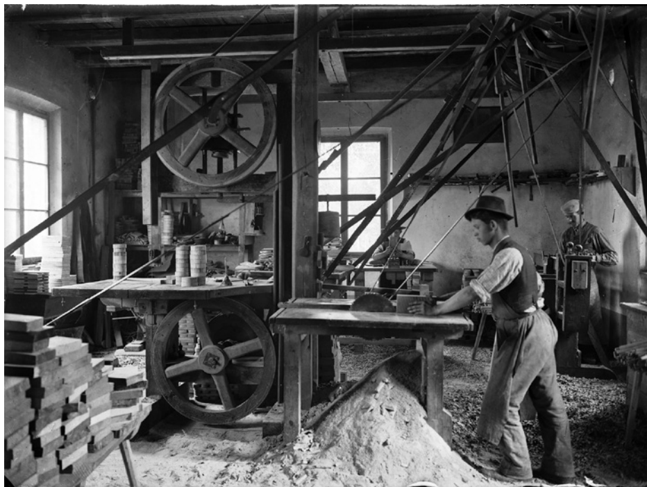
Strojna delavnica Nagličeve tovarne okoli leta 1930. V njej so izdelovali vse vrste lesnih polizdelkov, potrebnih za raznovrstno ščetarsko proizvodnjo. Nagličev komentar k posnetku: »Julij Jeran žaga, Peter Naglič struži, Janez Kočar vrta.« (foto: Peter Naglič)
