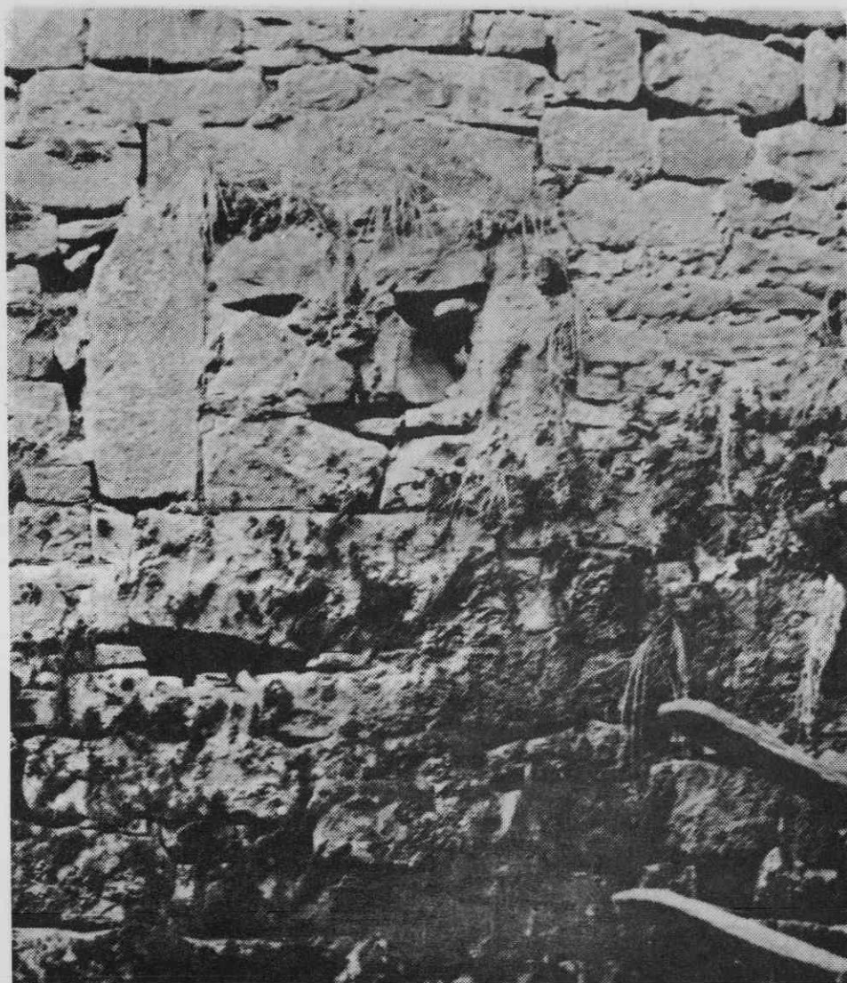
Sl. 12. Prvotno, danes zazidano okno na vzhodnem pročelju
