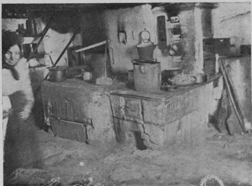
„Zid“ iz dimnice v Pernicah (Kóbansko).
