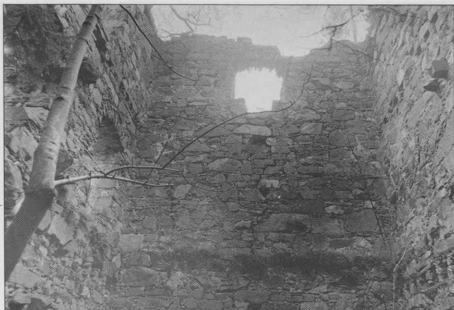
Sl. 14. Pogled na zgornji del južne obodne stene. Pod slabo ohranjeno okensko nišo je vidna tramovnica za vzdolžni podporni tram stropnikov prvega nadstropja. Trava raste na zidni polici v prvem nadstropju. ♦ View of the top part of the southern peripheral wall. Under the badly preserved bay window we can see the hole for the longitudinal supporting beam of the first floor's ceiling joists. Grass grows on the wall shelf in the first floor. ♦ Vue de la partie haute du mur de margelle sud. Sous la niche de fenêtre mal conservée on peut voir le trou dans le mur pour la poutre longitudinale de support des poutres du plafond du premier étage. Au premier étage, les herbes poussent sur l'étagère du mur.
