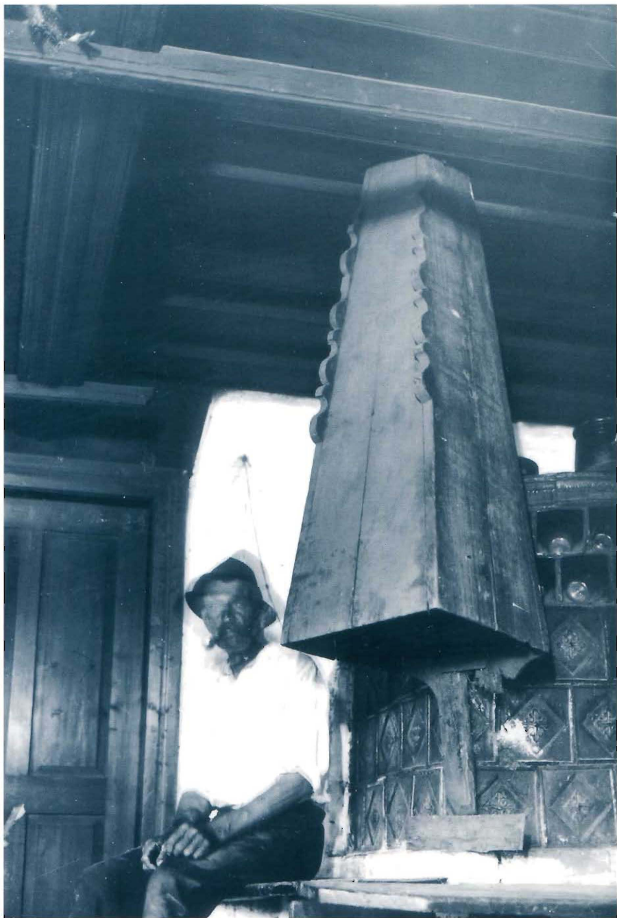
»Dimnjek«, naprava za odvođenje dima, Koprivnik, kraj 19. stoljeća
