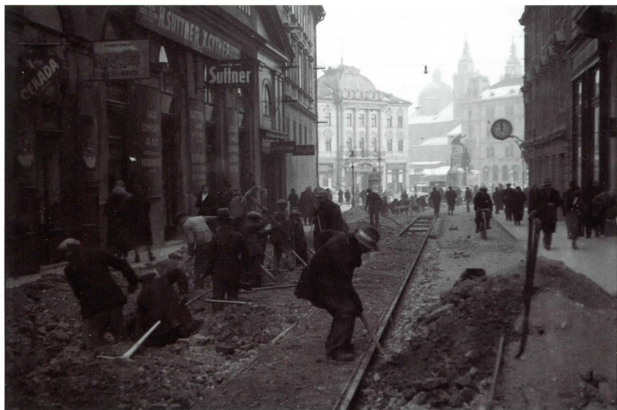
Gradnja tramvajske proge na Čopovi ulici v Ljubljani leta 1934.
