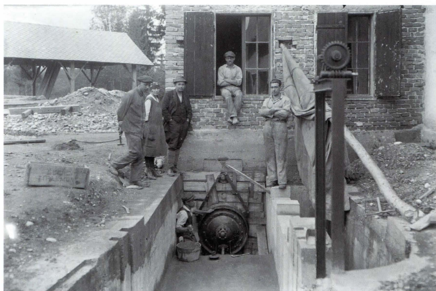
Vgradnja vodne turbine za Nagličev ščetarski obrat v Šmarci leta 1927.
