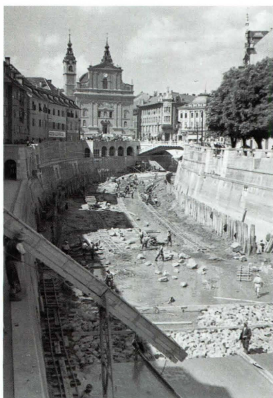
Betoniranje struge Ljubljanice leta 1934.
